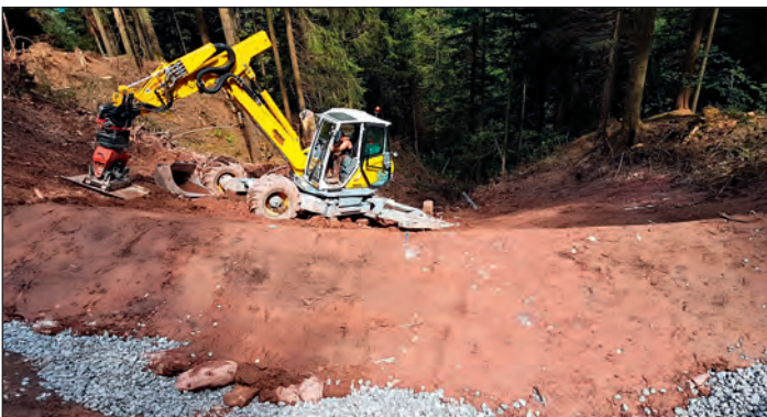
Abbildung 9: Fliessenstrasse: Verdichten mit Anbau-Plattenvibrator.
