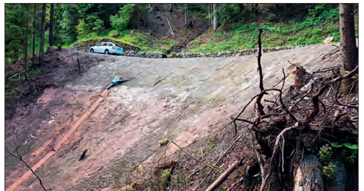
Abbildung 10: Fliessenstrasse: Drei Wochen nach Fertigstellung (Ende Juni 2016). Die beiden Holzkasten sind vollständig eingedeckt und in der Böschung nicht mehr sichtbar. Das Wasser aus dem Durchlass wird mit einem VKännel über die Böschung geleitet. Die Ansaat hat bereits gekeimt und die Böschung begrünt sich.
