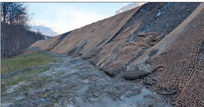
Abbildung 11: Auftragsböschungen mit Jutegewebe gesichert (Ende März 2017). Im Herbst 2016 wurde die Böschung erstellt. Über den Winter verursachte unkontrolliert abfliessendes Oberflächenwasser an exponierten Stellen Beschädigungen in der Böschung (Gemeinde Glarus Süd, Linthal: Baustelle im Projekt Linthal 2015 der Kraftwerke Linth-Limmern AG, 8783 Linthal).
