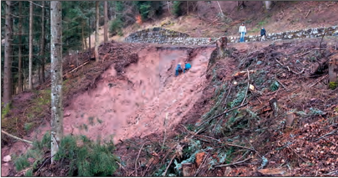
Abbildung 7: Fliessenstrasse: Rutschung im Frühjahr 2016. Die Rutschung reicht bis an den talseitigen Strassenrand und gefährdet die Strasse sowie deren Kunstbauten.
